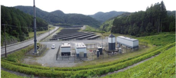
埋め立て完了後・諸施設稼働 2014年
