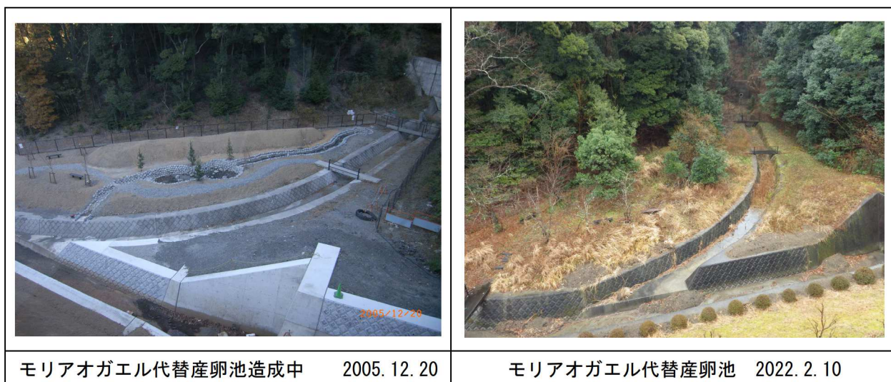
写真 5.2.16 モリアオガエル代替産卵池
