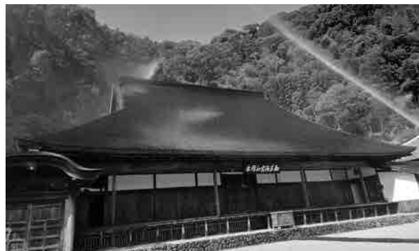
放水銃作動時
