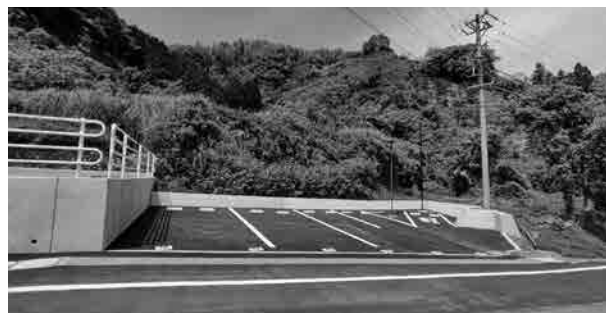
駐車場（下段）整備状況
