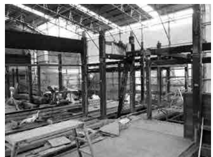
解体調査実施状況
