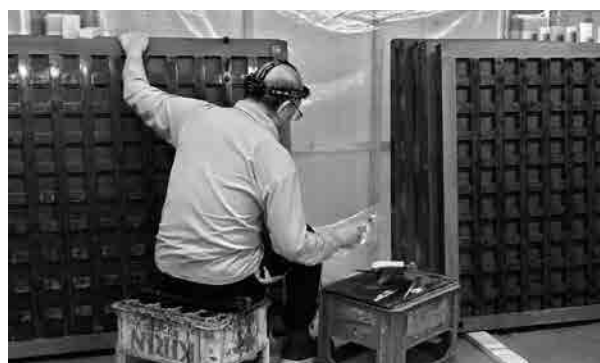
静岡浅間神社 修理現場
