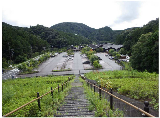
写真 4.3.4 田代地区 温浴施設 (2009 年供用開始) 2021. 8. 21
